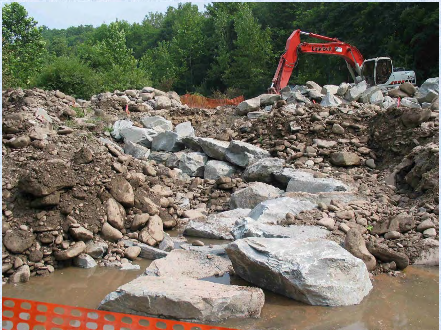
Constructing DS Boulder Weir
